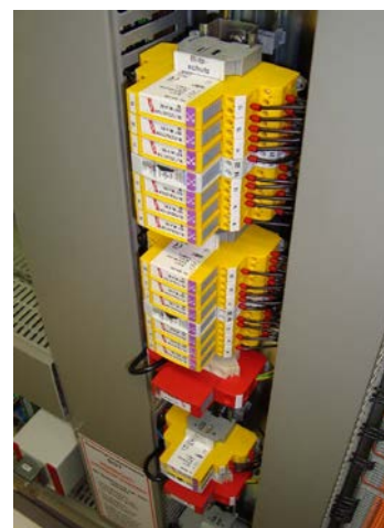
Blitzschutz auf KAG
